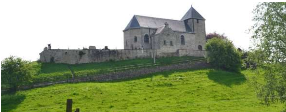
Site et monument classé à Lavoir © SPW-DGO4, S&A - 2016
