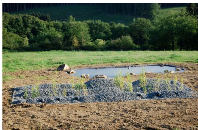
Mare aménagée qui accueille les eaux épurées en provenance de la lagune
