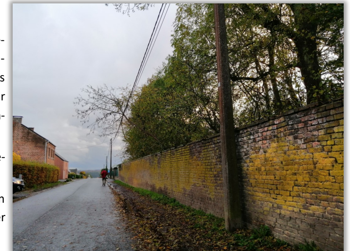
Manque d'entretien et accumulation de feuilles sur le trottoirs le rende peu praticable pour les piétons
