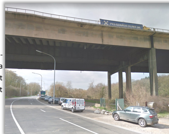
Stationnement non-autorisé sous la sortie 8 E42 (source : Street View)
